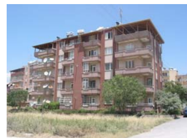
(c) SM-3: Akdeniz Apartman (Wohngebäude)
